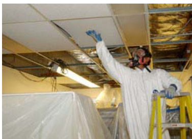
Dépose d'un faux-plafond contenant de l'amiante
