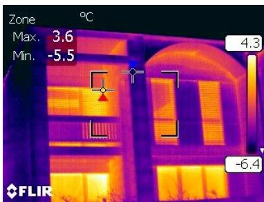
Thermographie de façade
