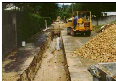
Réseau de Reconvilier : mise en terre des conduites de chauffage à distance
