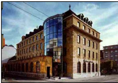
BCN, La Chaux-de-Fonds : bâtiment équipé d'un système de gestion technique centralisée
