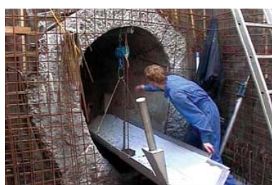
Pose d'un échangeur de chaleur en fond de collecteur d'eaux usées
