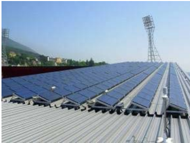
Une réalisation d'envergure dans le canton de Neuchâtel : le stade de la Maladière
