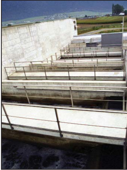
Bassins en escalier sur le toit de la STEP.
