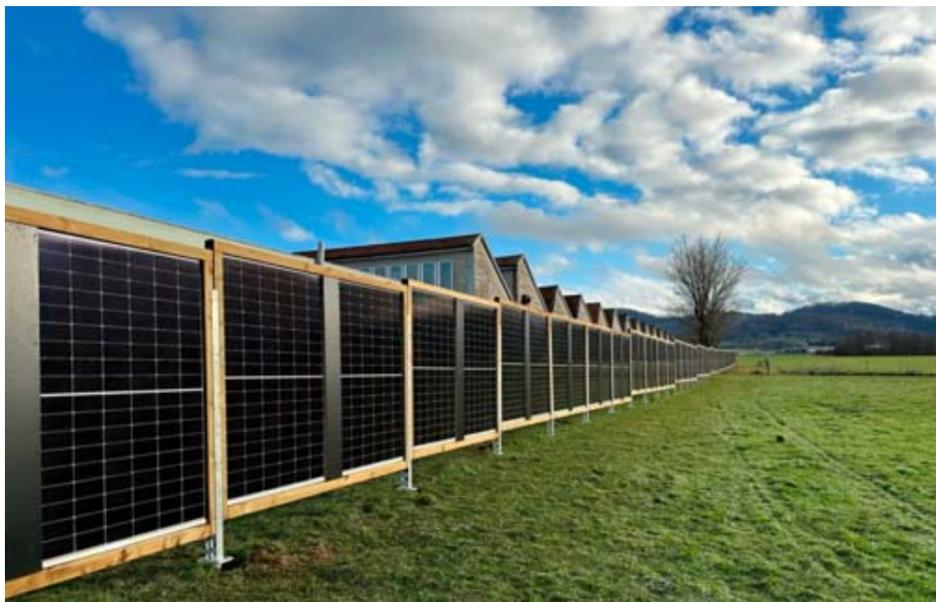
La palissade de panneaux photovoltaïques peut être démontée et réinstallée. En effet, outre les fixations non cimentées dans le sol, tout le système électrique est intégré aux panneaux. Aucun fil ne dépasse. DR
