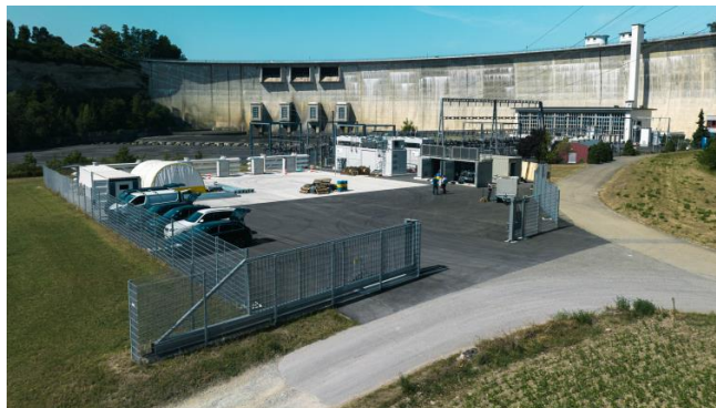
Exemple en Suisse, Schiffenen: 2 MW couplé à un barrage
