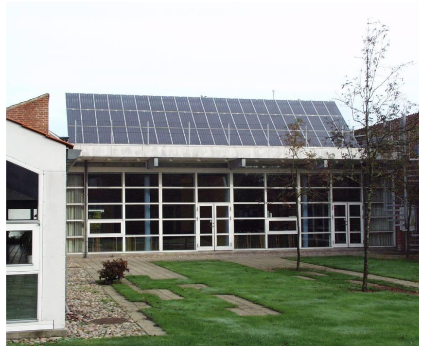
Solar in Brædstrup, 6 kWp, 1993
